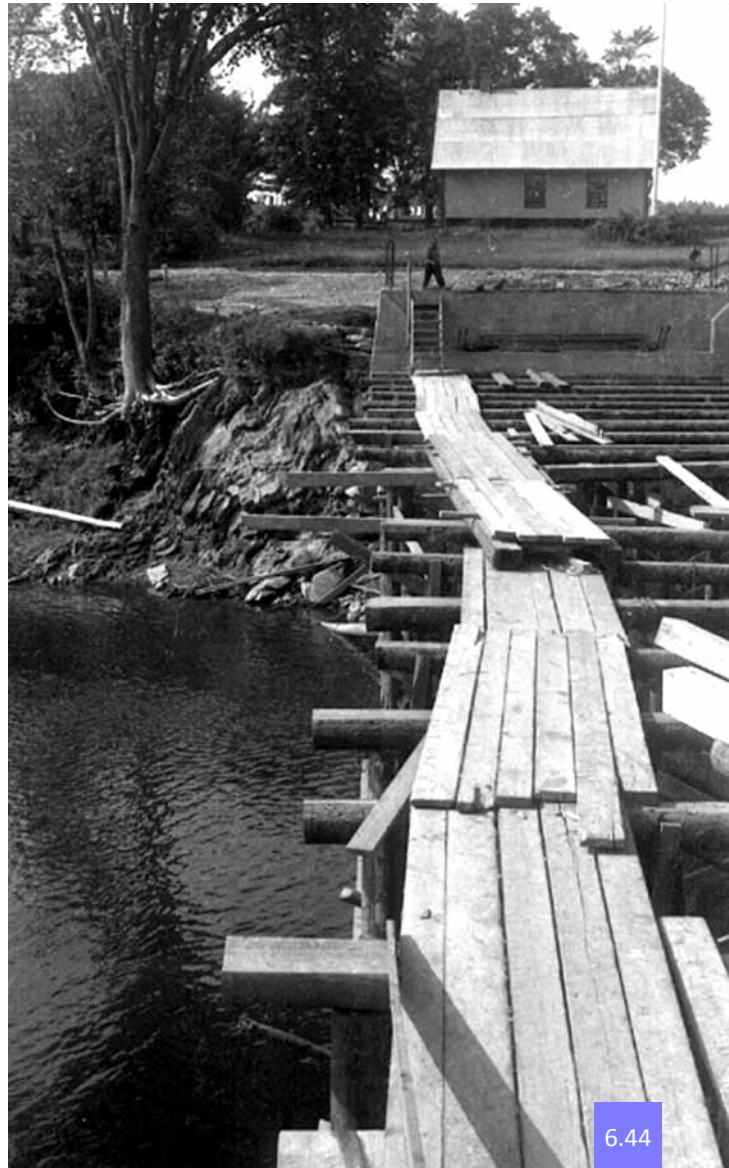
6.44 Construction du nouveau pont sur la rivière aux Saumons. L'école de rang est visible en arrière-plan. Source : L. LANGLOIS. Pont sur la rivière aux Saumons à Huntingville, comté de Sherbrooke . 1943. © Bibliothèque et Archives nationales du Québec (BAnQ), cote E6S7SS1P14763 [en ligne]
